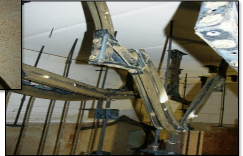
Extrém lehajlási értékek még a kettőzött sínek esetén is
